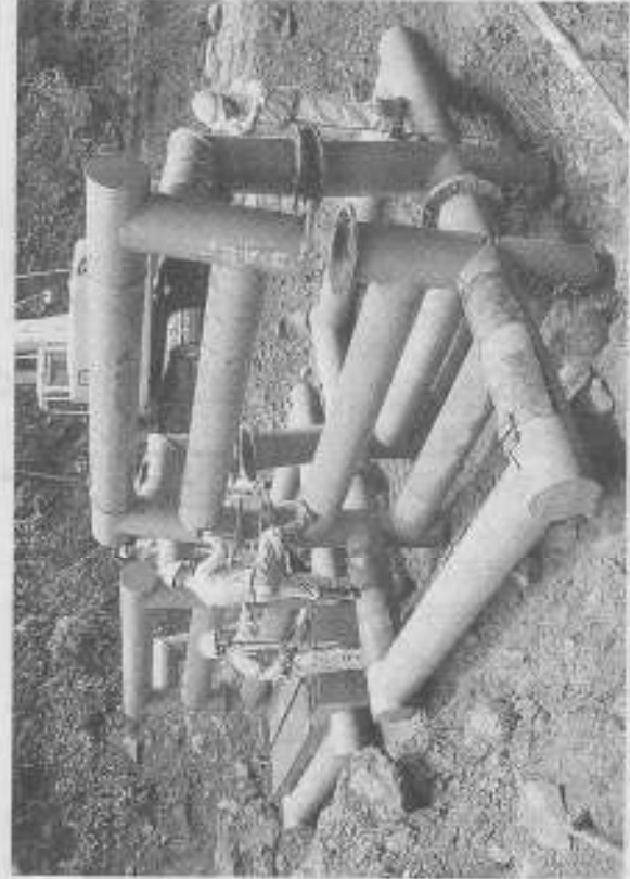
流木などをせき止めるために設置された鋼製牛杵—8日 午前、高崎町高崎川・高崎川
